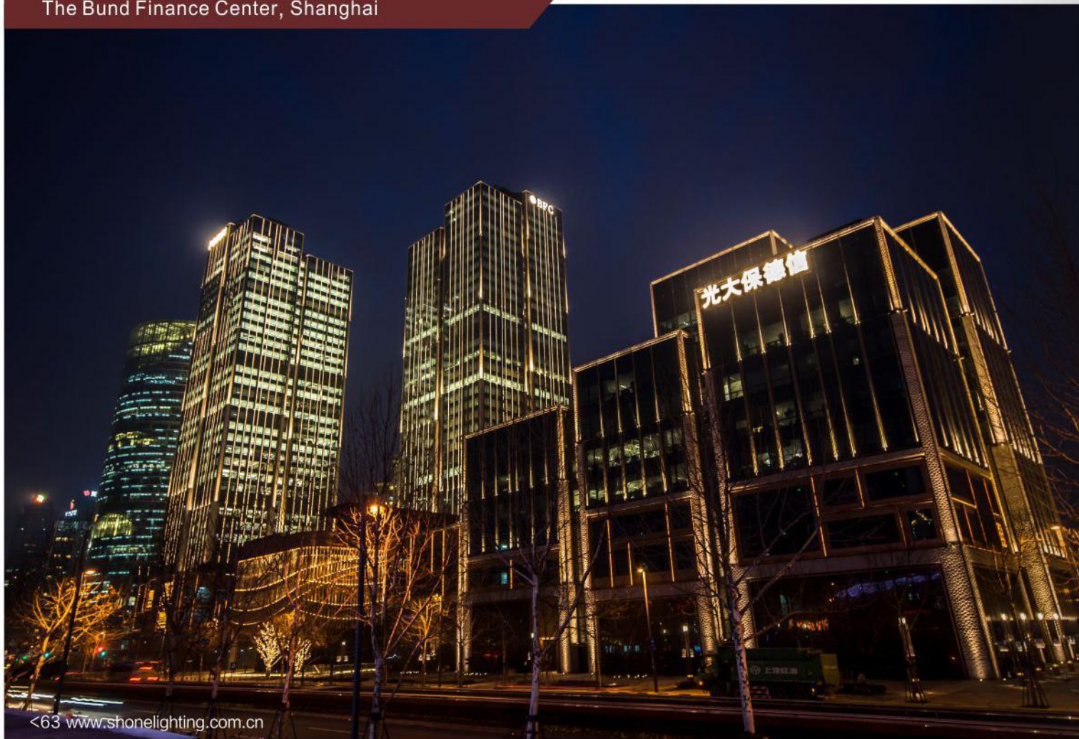
上海外滩国际金融服务中心 The Bund Finance Center, Shanghai
